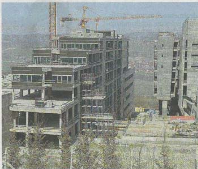
Il cantiere del nuovo ospedale.
